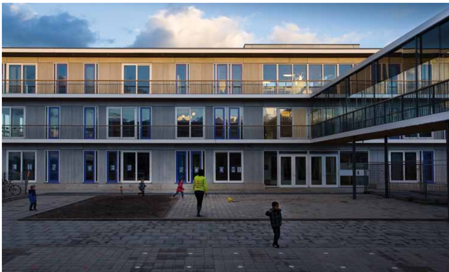
De galerijen van MFA Keijzershof zijn esthetische elementen én doen dienst als zonwering en vluchtroute.
