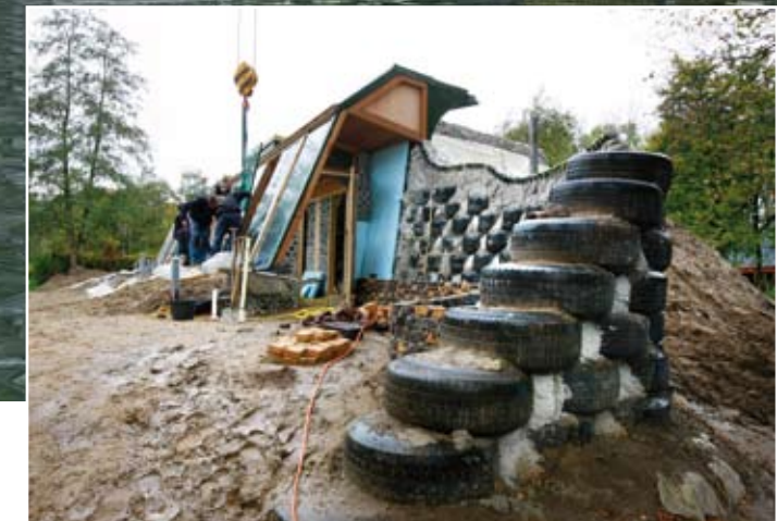
Het Earthship in Zwolle van de Amerikaanse architect Mike Reynolds maakt onder andere gebruik van autobanden, glazen flessen en afgeschreven tegels als bouw materiaal.
